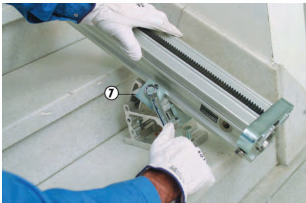
Монтаж на релсова пета с пета с наклонени и стъпаловидни разрези
